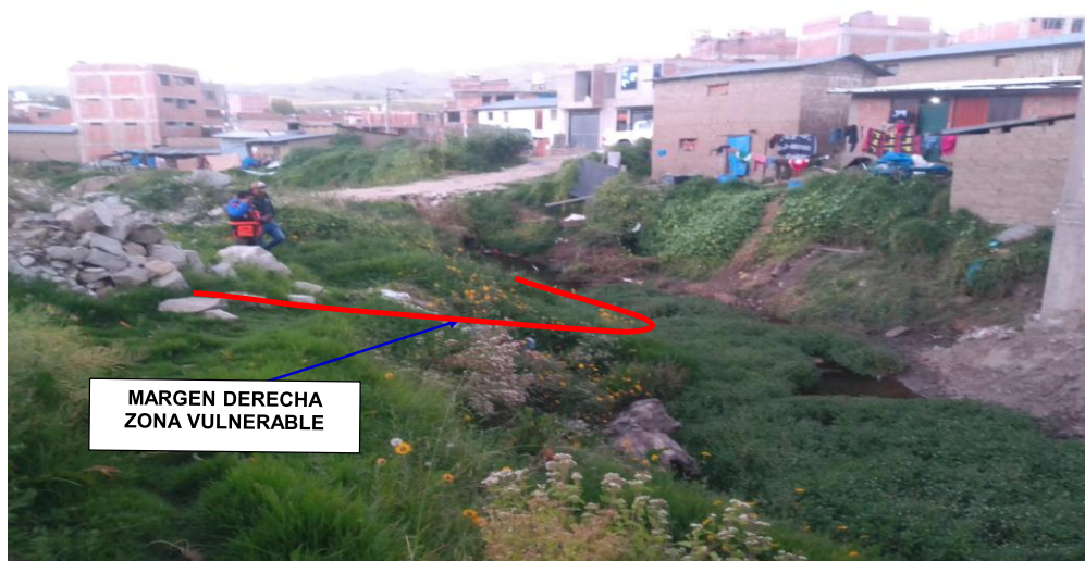
FIGURA N° 02: QUEBRADA ALCCOCHACA EXPUESTO ANTE INUNDACION POR LA MARGEN IZQUIERDA POR RELLENO DE MATERIAL SUELTO.
