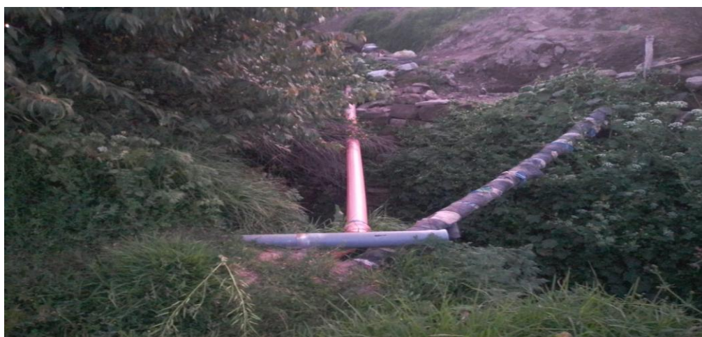
FIGURA N° 03: QUEBRADA ALCCOCHACA EN LA TEMPORADA DE MAXIMAS AVENIDAS AFECTO CON SOCAVAMIENTO EN AMBAS MARGENES CON LA INSTACION DE TUBERIAS DE DESAGUE EN EL CERCADO DEL DISTRITO.
